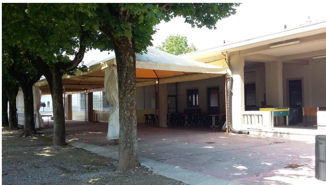
Foto 2 – Edificio oggetto di intervento, lato sud-est
