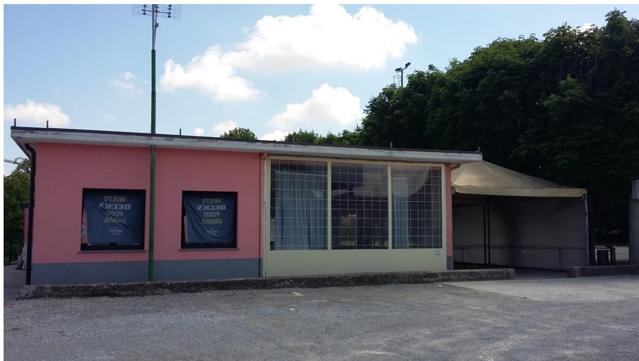
Foto 1 – Edificio oggetto di intervento, lato ovest
